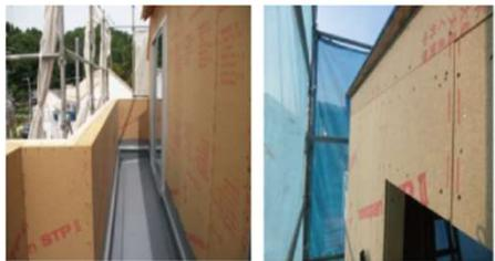
垂直方向の力に対しては柱が、水平方向の力には梁が抵抗し、柱や梁とは別に筋かいや金物で耐震性を確保しております。デックスでは、構造用合板を張り、さらに耐震性を高めて施工しています。間取りの自由度とこの耐震性能により、長期的に安心で快適な建物づくりをしています。
