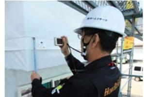
防水材の重ね長さや防水の立ち上がり高さ等の施工状況を検査します。
