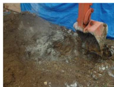
地層の土とセメント系固化材を混合搅拌し、固化させることで地盤強化と沈下抑制を図る工法です。地表面から深い部分の補強に適しています。
