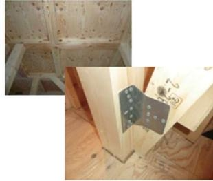
構造部材の種類や寸法の施工状況を検査します。
