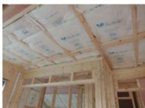
断熱材の種類や厚さ施工箇所等の施工状況を検査します。
