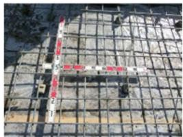
コンクリート打設前の内部配筋の鉄筋寸法や施工状況を検査します。
