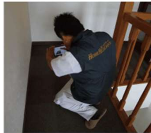
入隅の隙間、亀裂などの確認
