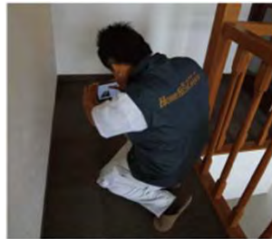
入隅の隙間、亀裂などの確認
