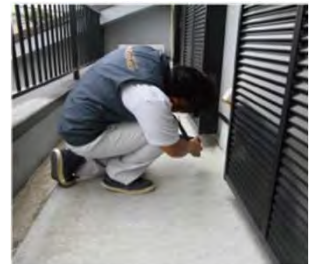
防水層の劣化、亀裂等の確認
