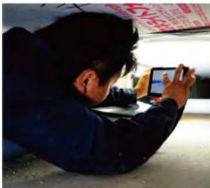
基礎のヒビ、カビ、腐食の確認
