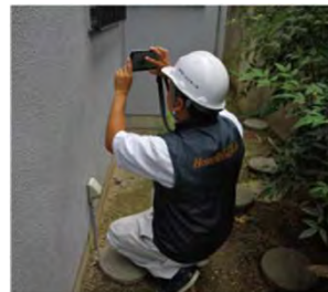
サッシ周りの隙間確認
